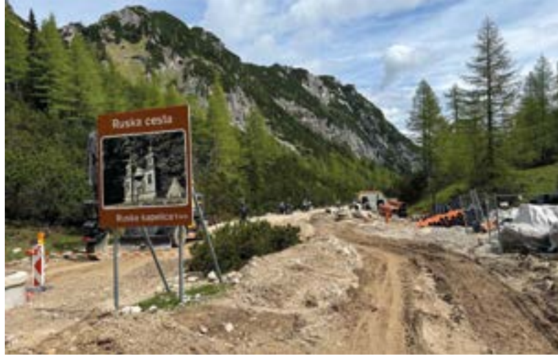
Hindernislauf: Die Baustelle auf der Passhöhe beschert uns ein kurzes Schmodderstück als Abwechslung
